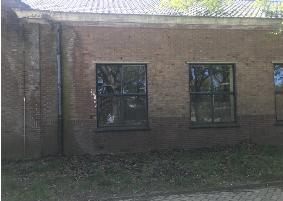
Detail van de noordgevel. De sprong links op de foto laat zien waar in de jaren zestig de eetzaal tegen het voormalige badhuis werd aangebouwd. Het linkerdeel dateert uit 1950, het gevelvlak met de drie vensters uit 1963, 2020
