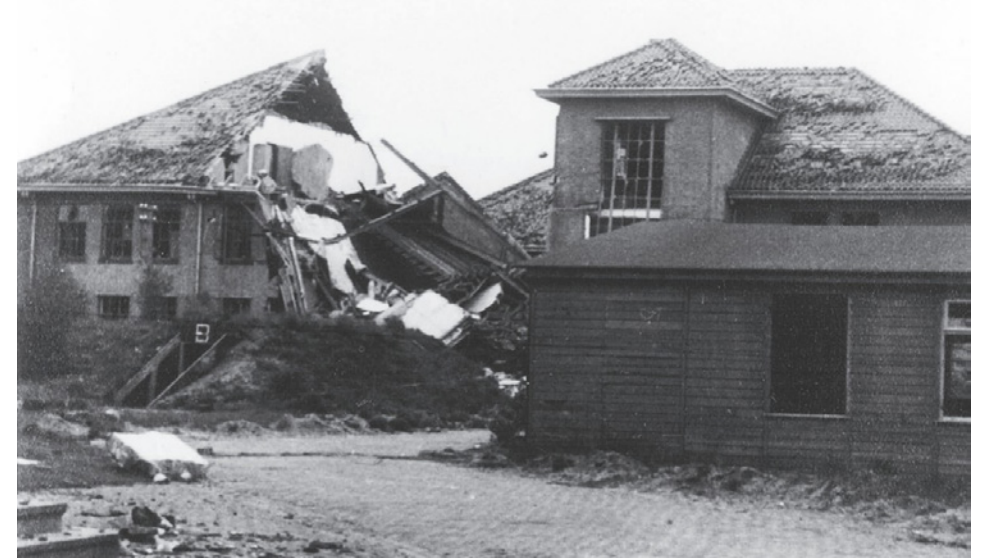
Schade aan een legeringsgebouw na de geallieerde bombardementen in 1944 (B.C. Cats, 50 jaar Palmkazerne)
