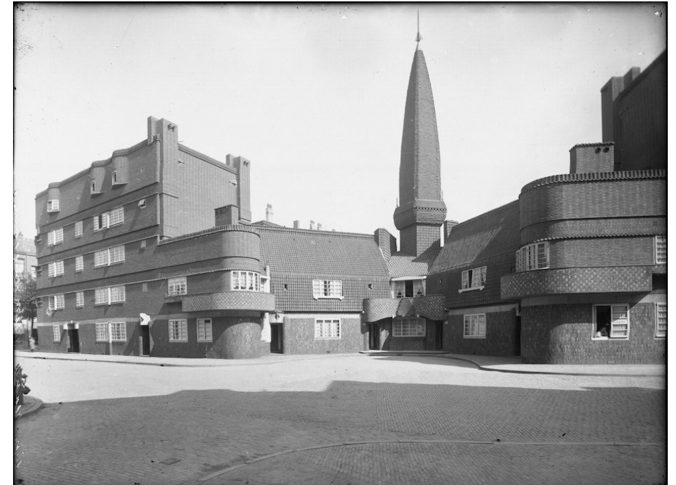
Woningbouw in de Spaarndammerbuurt in Amsterdam (bomcollab.com)
