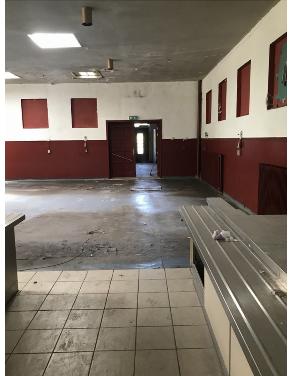
De rode muurvlakken zijn zeer waarschijnlijk de oorspronkelijke gevelopeningen
