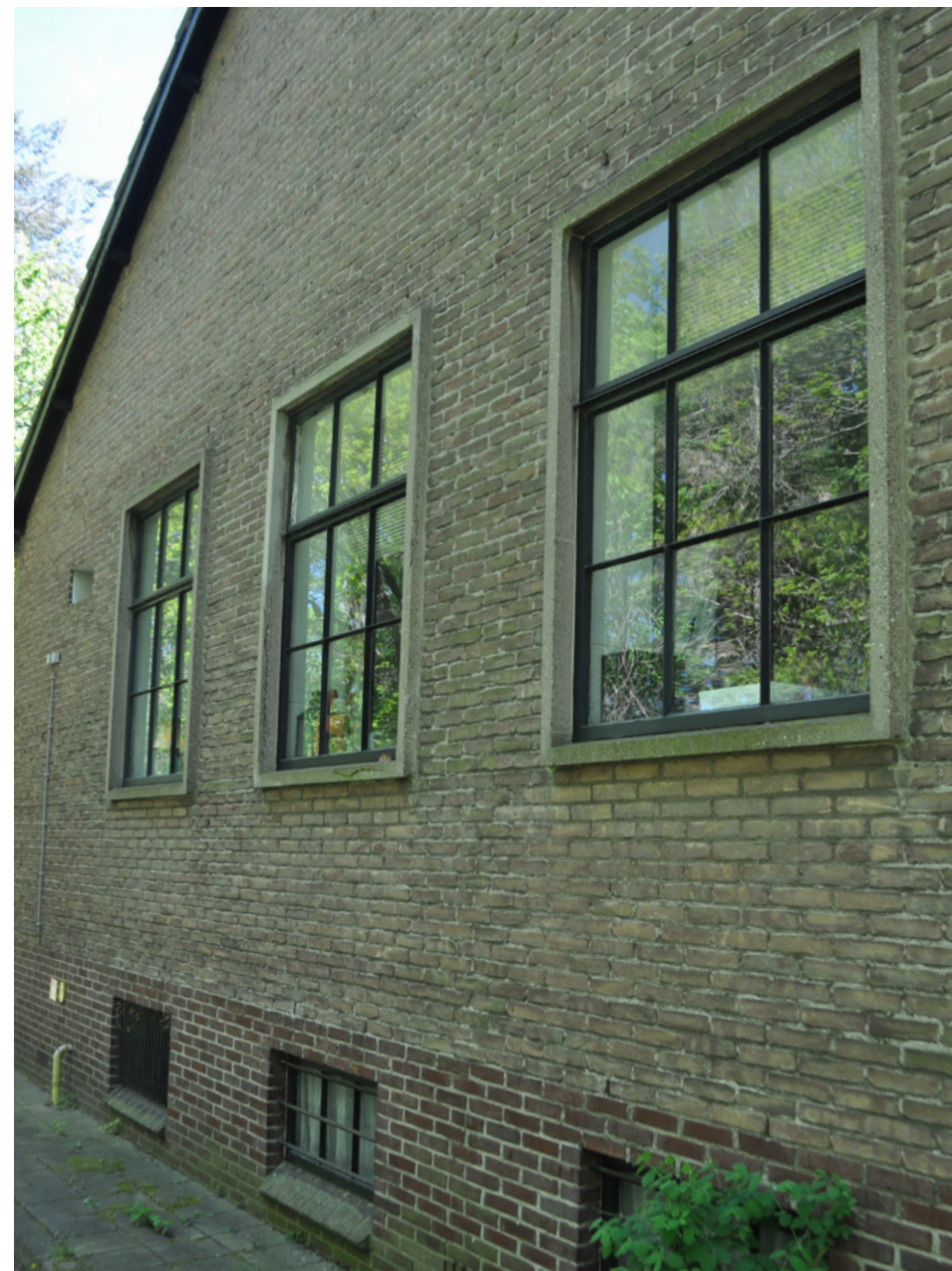
Ramen in de noordelijke kopgevel met betonnen omlijsting
