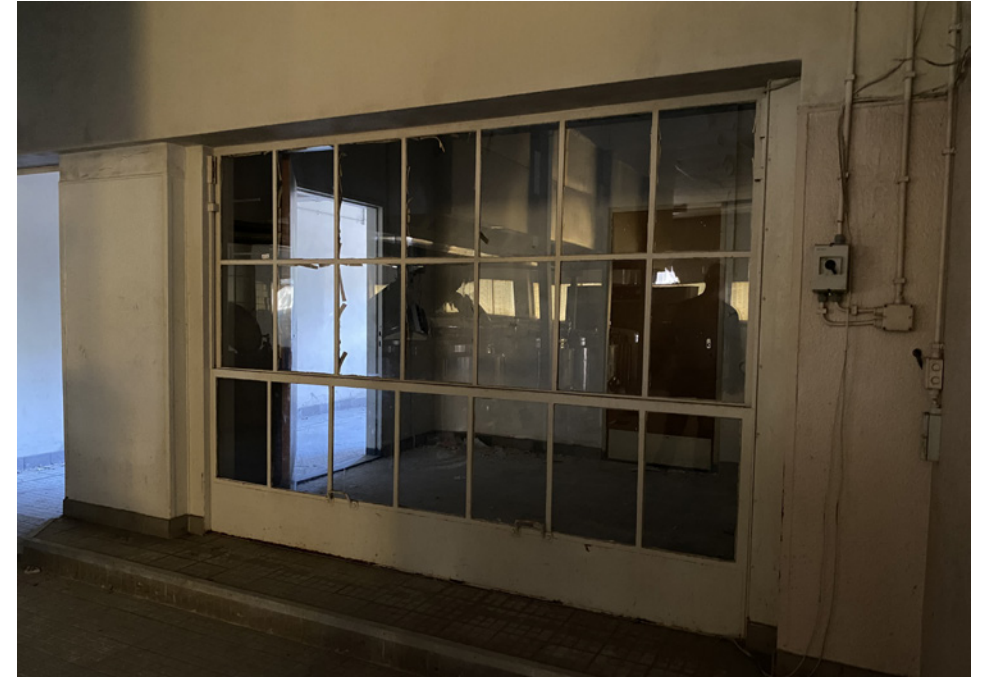
Stalen kozijnen in het keukengebouw
