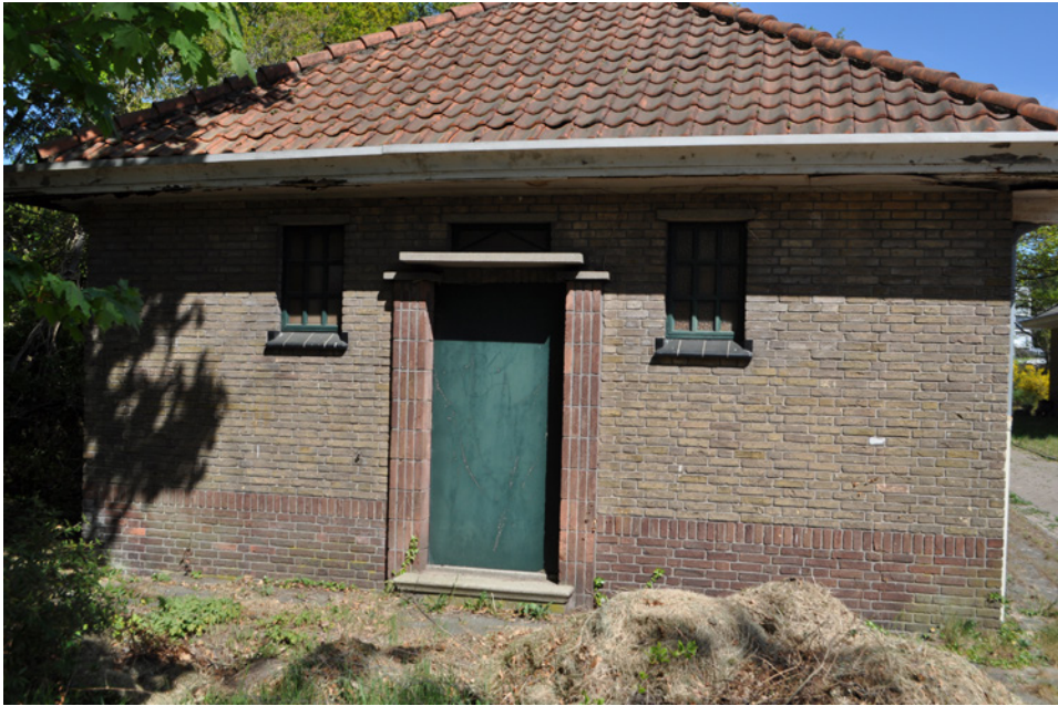
Kopgevel, entreepartij met bovenlicht
