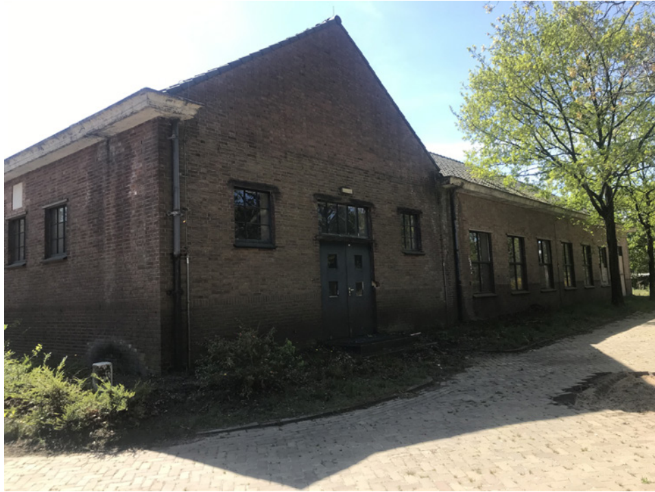
Noordgevel en een deel van oostgevel. Het deel links op de foto is het voormalige badhuis, te herkennen aan de hoog geplaatste stalen vensters. Het rechtse deel op de foto is de eetzaal die in 1963 is aangebouwd
