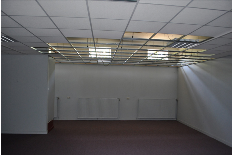
Interieur met een systeemplafond opgehangen aan het oudere tussenplafond
