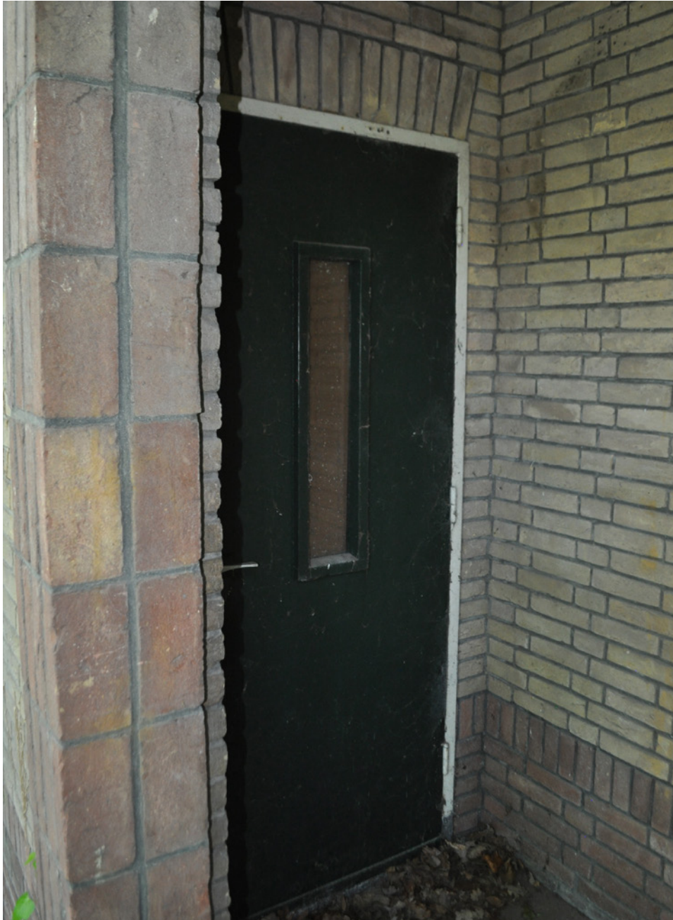
Ingang achterzijde gebouw 7
