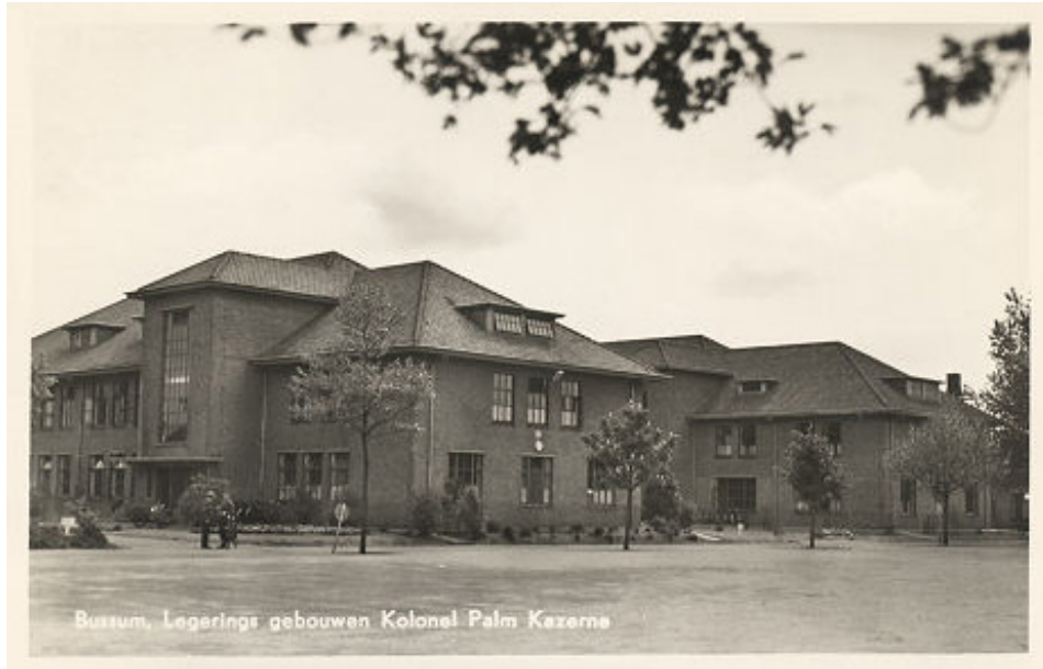
In elkaar grijpende schilddaken waarvan de vorm afgeleid is uit de contouren van de onderliggende gebouvvolumes (legerplaats.nl)
