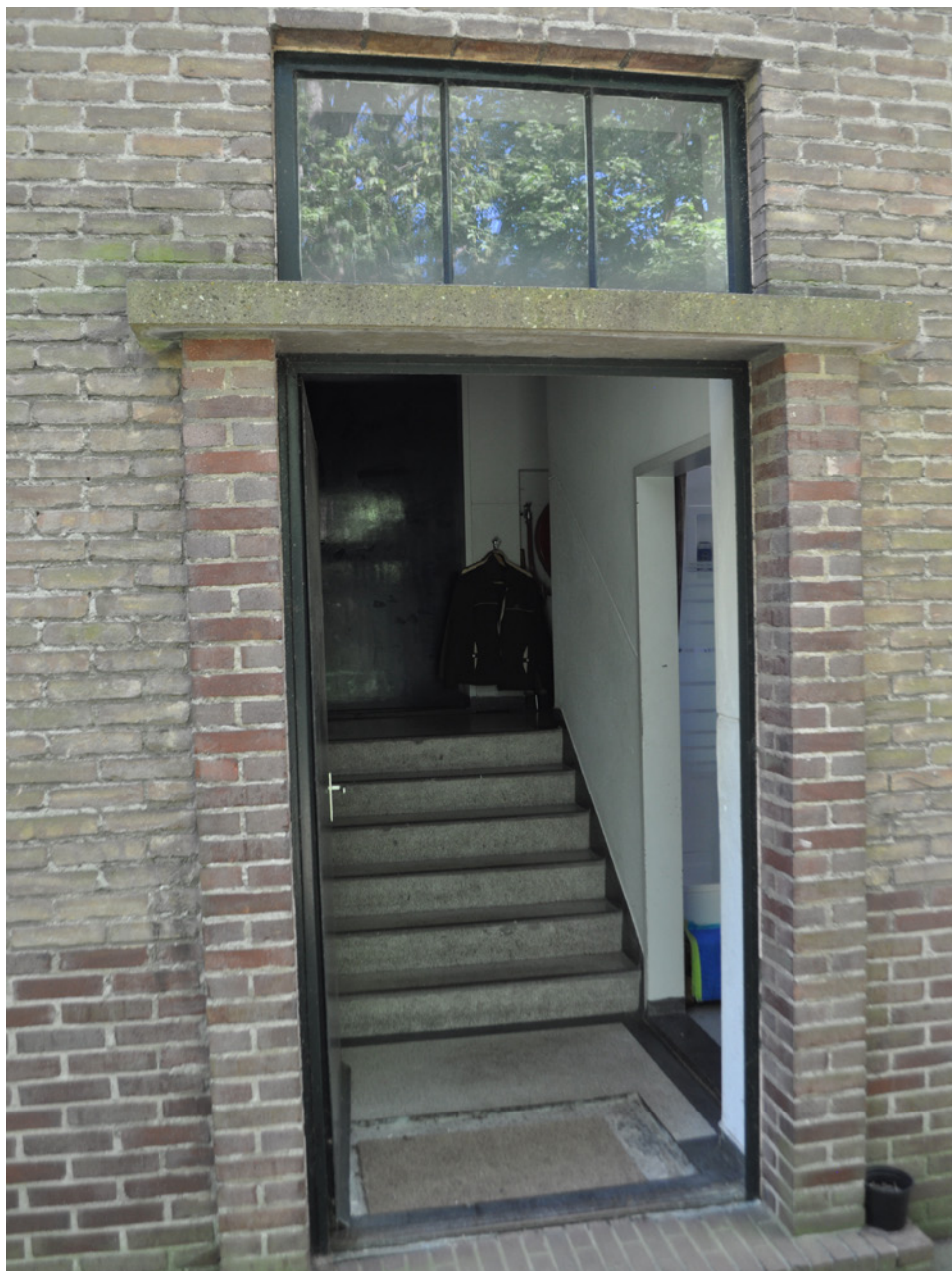
Entree met bovenlicht in de noordelijke kopgevel
