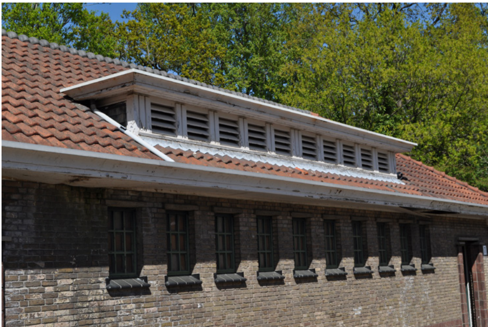
Belangrijke details herinneren aan de oorspronkelijke functie, zoals de dakkapel, hoge vensters en zwaar uitgevoerde gootlijst
