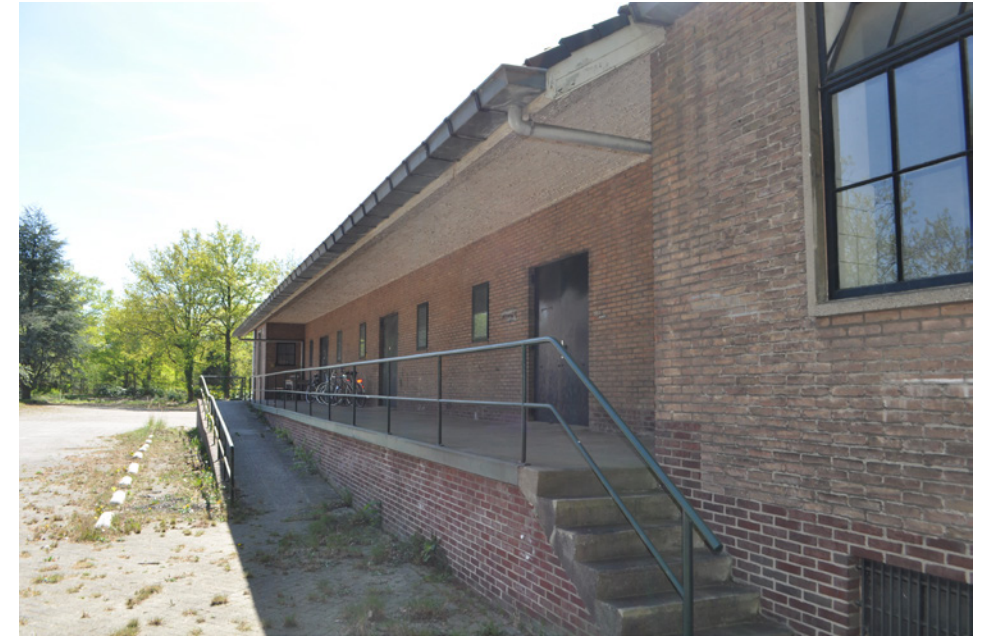
Laadperron aan de oostgevel
