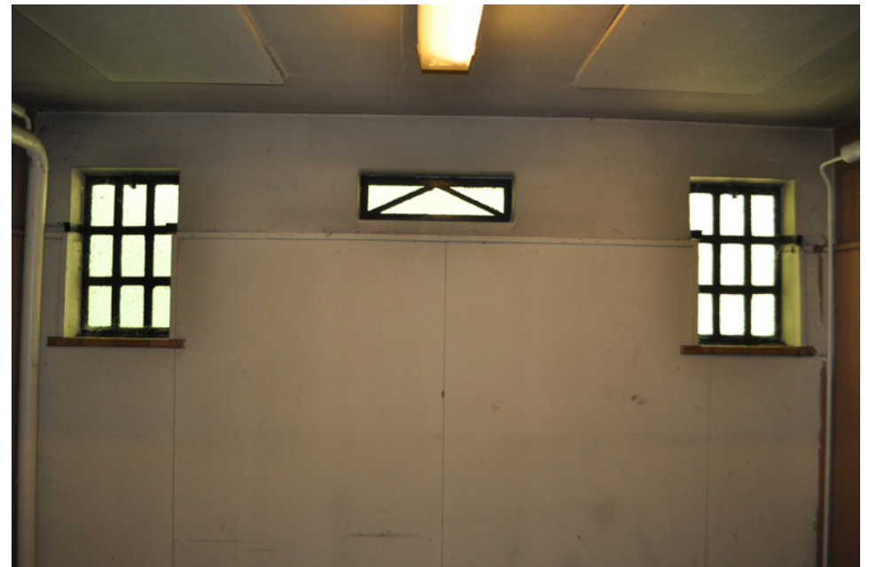
Ingangen aan de kopse kanten zijn afgesloten
