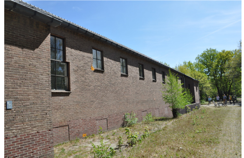
Westgevel, meest linker raam is uitgebroken en vergroot
