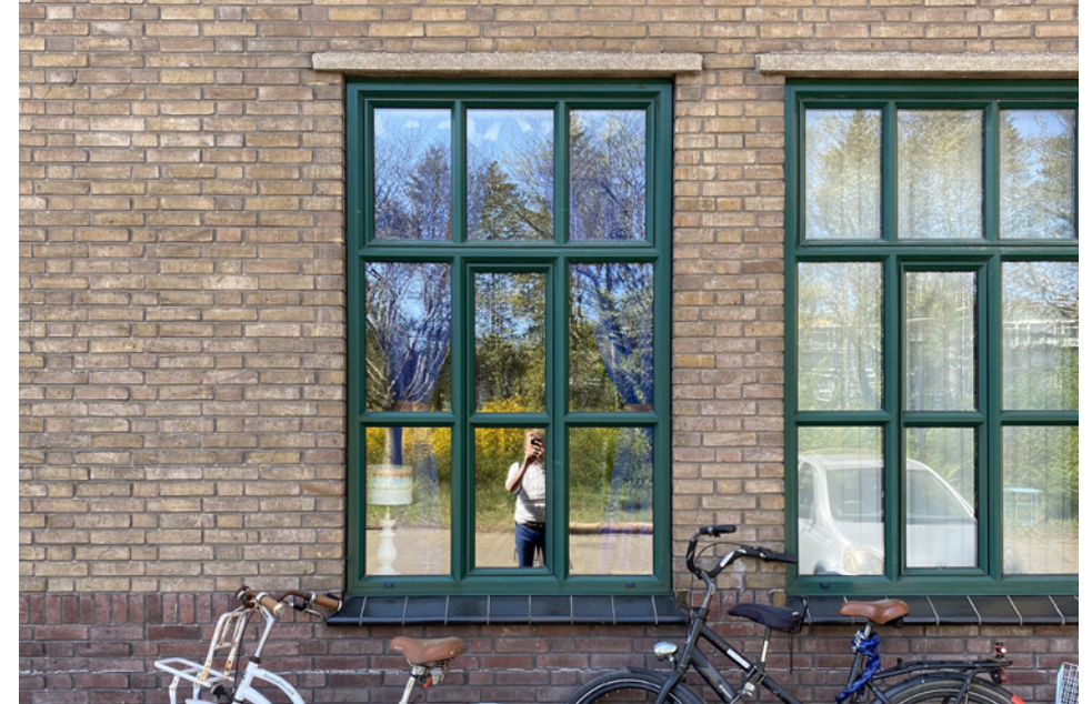
Groene kunststof kozijnen geplaatst ter vervanging van de oorspronkelijke stalen kozijnen
