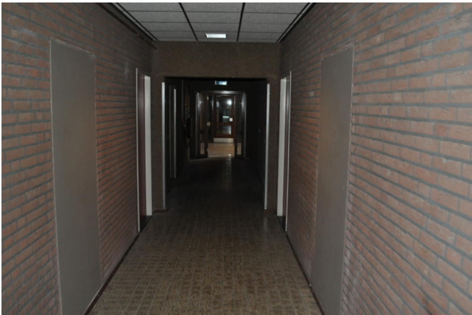
De gang met wanden in schoon metselwerk
