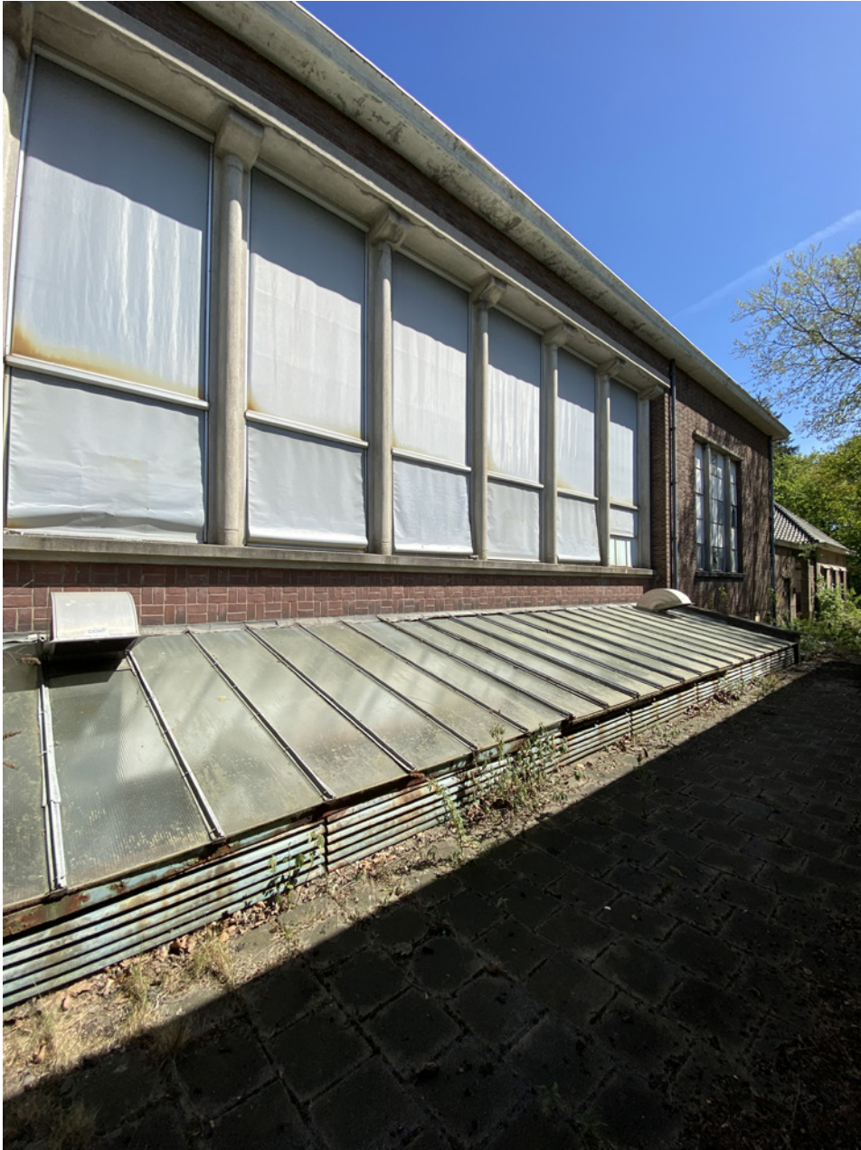
Grote betonnen vensters in de westgevel van het keukengebouw
